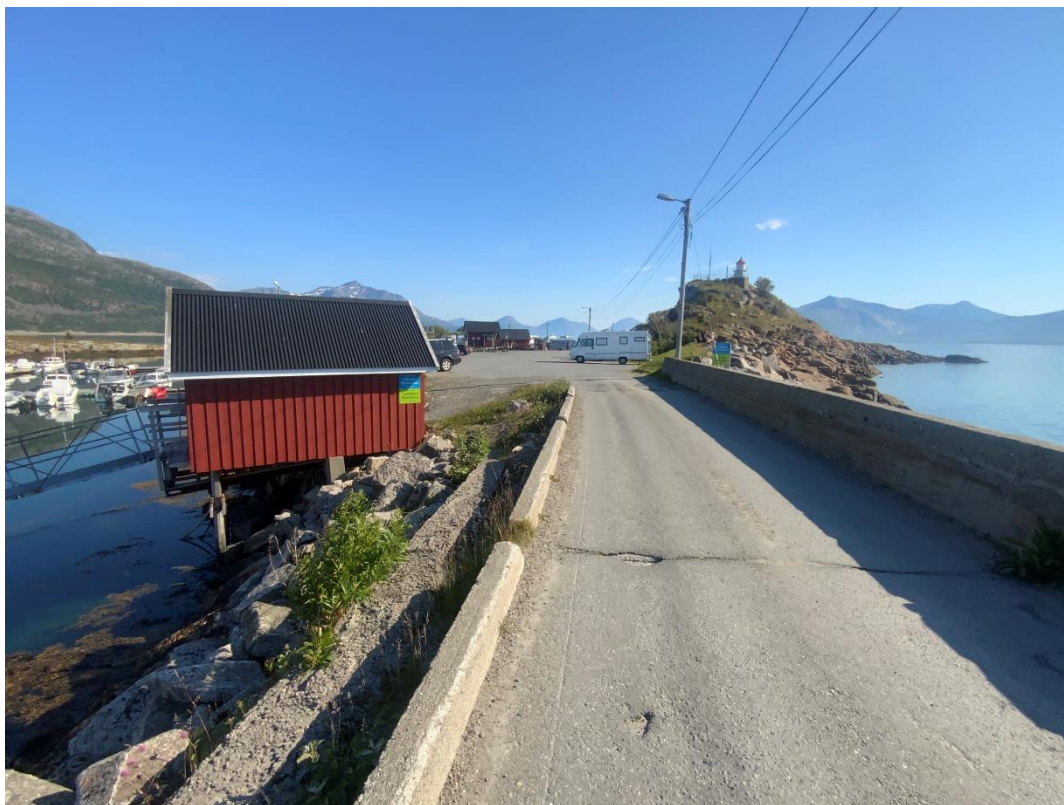
Figur 6. Moloveien. Foto: Rambøll.
